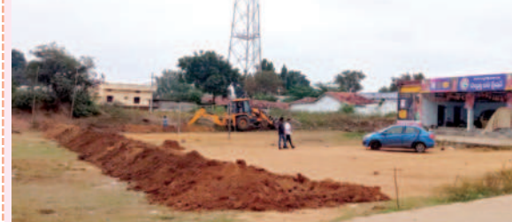
ప్రహరీ గోడ నిర్మాణ వసూలు కొనసాగుతున్న దృక్పథం
